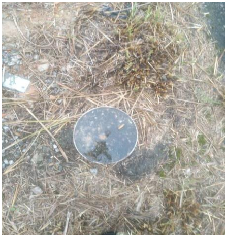
坝体位移沉降观测桩
