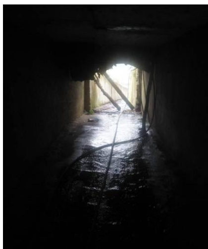
排水涵洞出口
