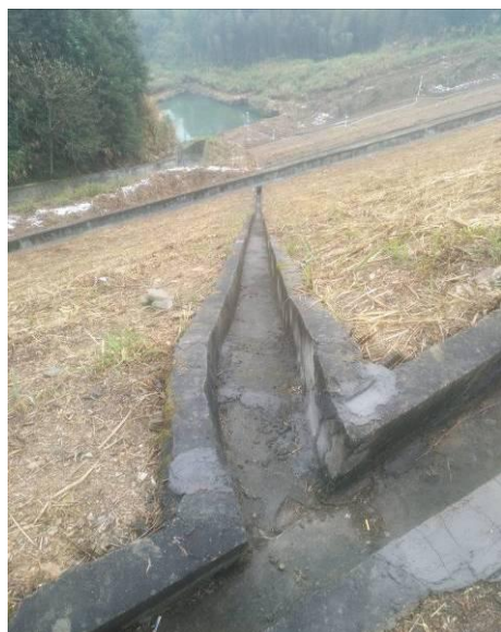
尾矿坝外坡面排水沟
