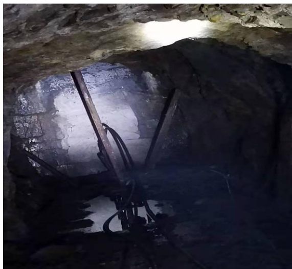
原西干渠隧洞封堵
