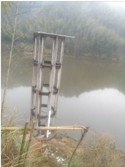
排水井库水位监测仪与标尺
