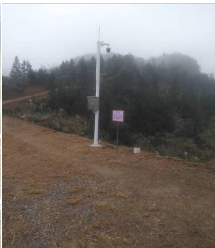
坝体外坡面、消力池、坝顶视频监控仪
