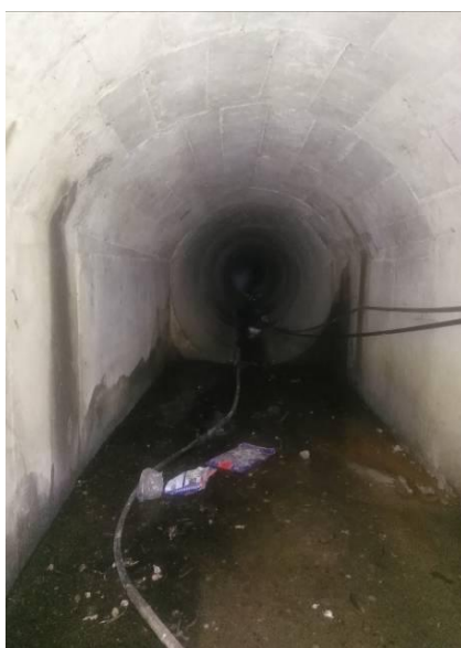
排水涵洞进口
