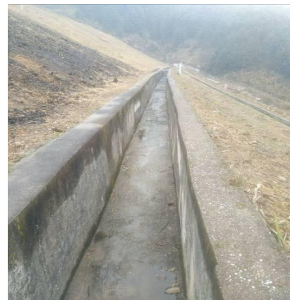
西干渠坝体段明渠
