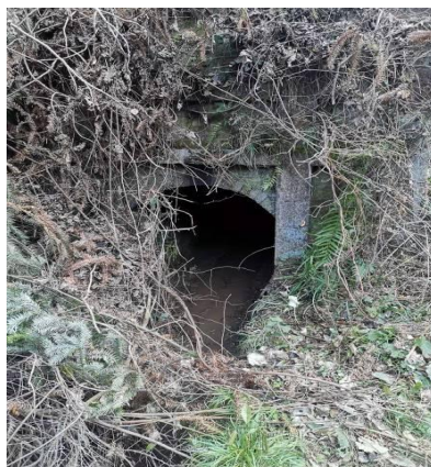
西干渠改线隧洞
